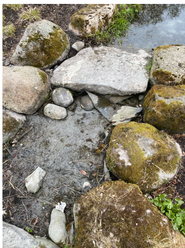
Figur 31: Slitasepunkt ved steinovergangene i øvre del av Niagara hvor duken har løsnet. Foto: Nummelin, M.
