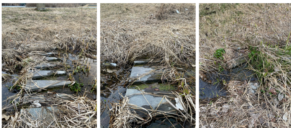
Figur 13: Tersklene i Fougnerstryket er anlagt for å bremse vannhastigheten. Foto: Nummelin, M.
