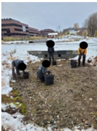
Figur 24: Fjerning av kulestein fra sedimentasjonsdam i Uraksen. Foto: Arnott, D.
