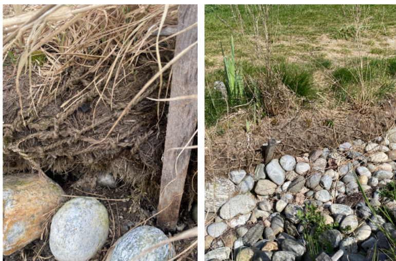
Figur 28: Kokosnøttfiber er lagt langs kanten i bekkeløpet for å holde løsmasser på plass, men vannet har tatt med seg mye av jordsmonnet rundt. Foto: Nummelin, M.
