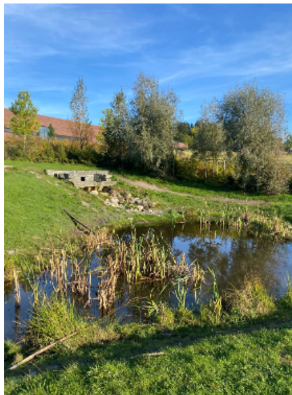
Figur 21: Forsedimenteringsdammen kunne med fordel vært større slik at man unngikk oversvømmelser i området når det er store mengder avrenning fra Veterinærbygningen. Foto: Nummelin, M.
