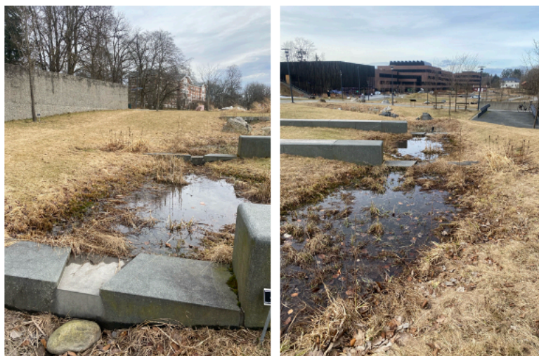
Figur 22: Dammene kunne med fordel hatt høyere terskel fordi de da hadde holdt på mer vann. Foto: Nummelin, M.
