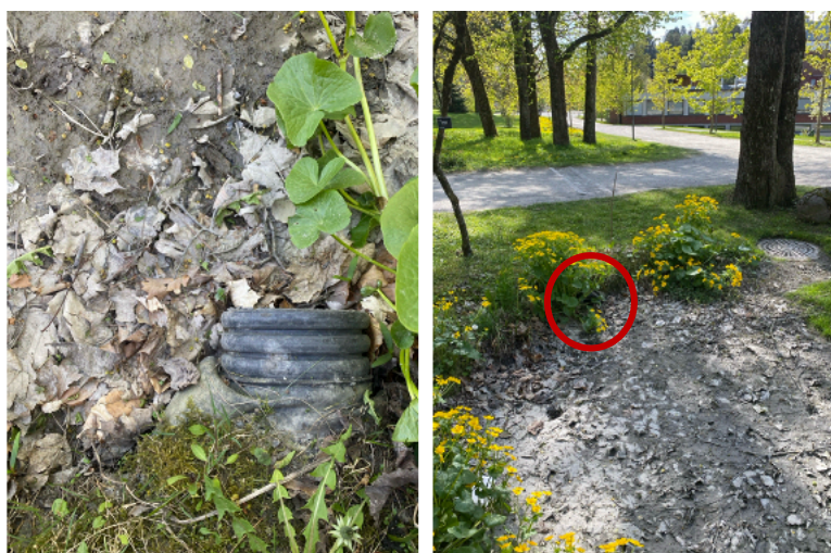
Figur 33: Røret til venstre i bilderekken blir strupet, og vannet ledes til kummen på bildet til høyre. Den røde sirkelen visere hvor røret går under grusveien. Foto: Nummelin, M.
