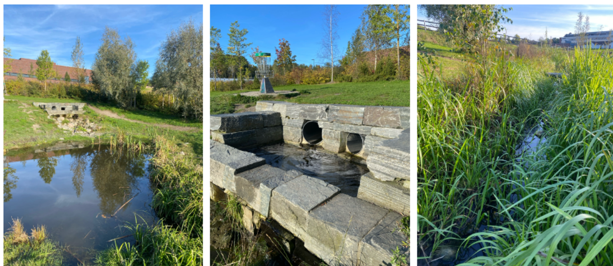
Figur 16: Bildene til venstre viser forsedimenteringsdammen med utløpet i bakgrunnen. I midten er mottakskulpen og de to rørene som leder avrenning fra området rundt Veterinærbygningen. Lengst til høyre er kanalen som leder vannet ned til den konstruerte våtmarken. Foto: Nummelin, M.
