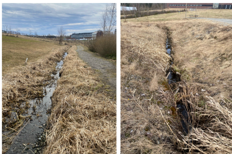
Figur 27: De rette, smale og lange bekkeløpene som er anlagt i den konstruerte våtmarken gjør at det blir høy vannhastighet. Foto: Nummelin, M.
