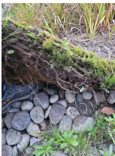
Figur 25: Kokosfibermatter plassert direkte på kulestein, og man kan se at plantene ikke har slått røtter i jordsmonnet ettersom kulesteinlaget er så tjukt. Foto: Arnott, D.
