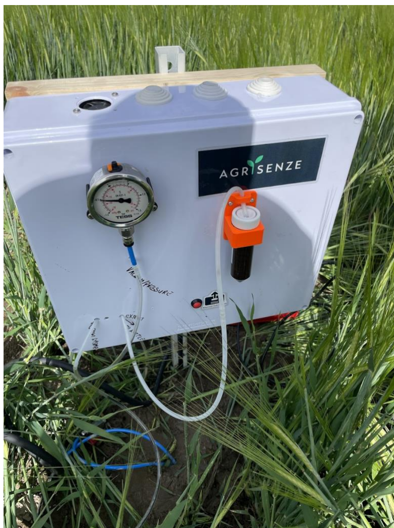
Figur 3-8 AgriSenze sin installasjon ved P2, Pilotfeltet, for innsamling av porevann.
