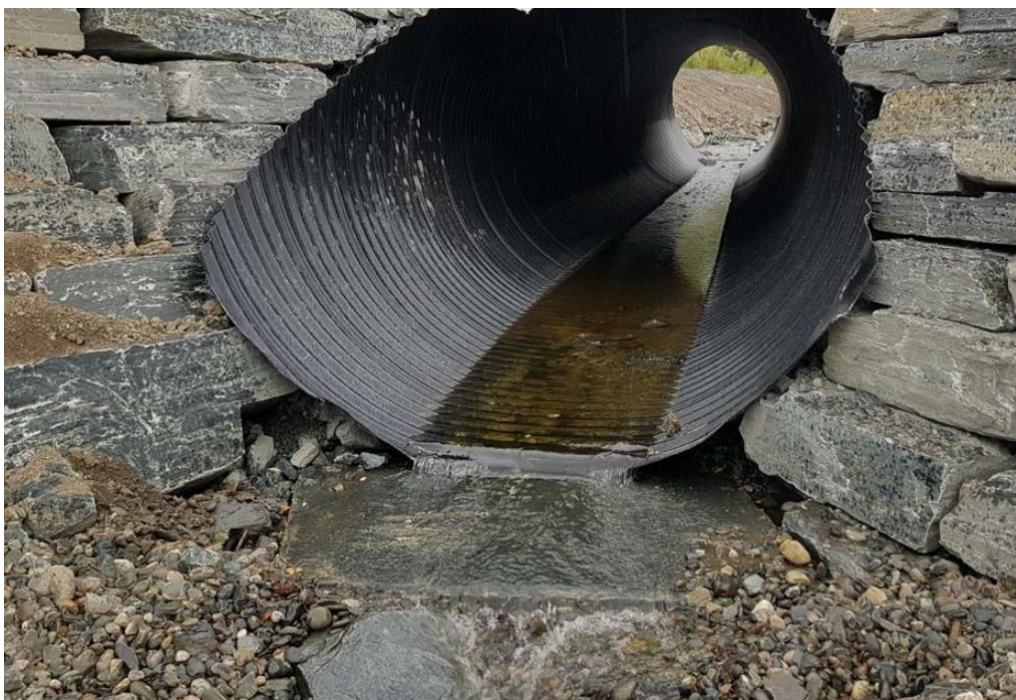
Figur 17. Kulvert 2 etter ferdigstilling, sett på lav vannføring. For høy plassering av rør med svært lav vannstand både gjennom røret og nedstrøms utløpet, samt uheldig steinhelle ved utløp. (foto: Stian Stensland).
