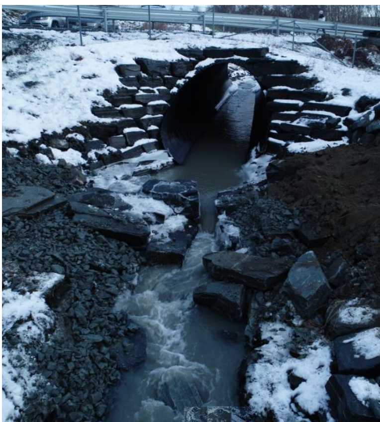
Figur 19. Bildet viser området etter at NVE utførte opprettingsarbeid, med fortsatt vanskelige forhold for fisk. NVE påpekte i ettertid at det bør konstrueres nytt elveløp (personlig kommunikasjon, NVE, 16. feb. 2023) (foto: Bane Nor)
