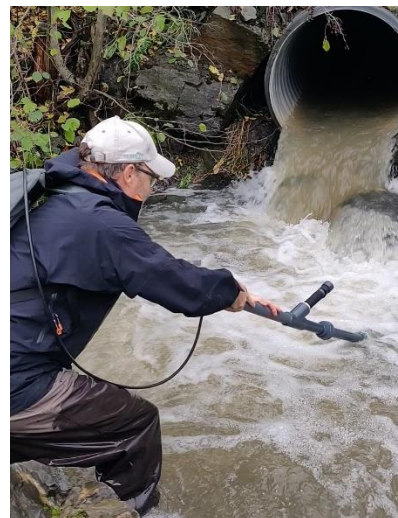
Figur 47: Veileder Thrond Oddvar Haugen skanner etter merket gytefisk med bærbar antenne nedenfor stri kulvert under Vukuvegen. Dette er et hinder som kan selektere for stor fisk med høy svømmekapasitet.
