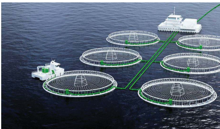
Figur 12: Strømforsyning ut til merdkant slik at båter kan arbeide og lade ved merdkant og flåte (Bellona and ABB, 2019).
