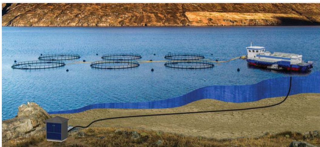
Figur 8: Oppdrettsanlegg elektrifisert med landstrøm (JM Hansen).
