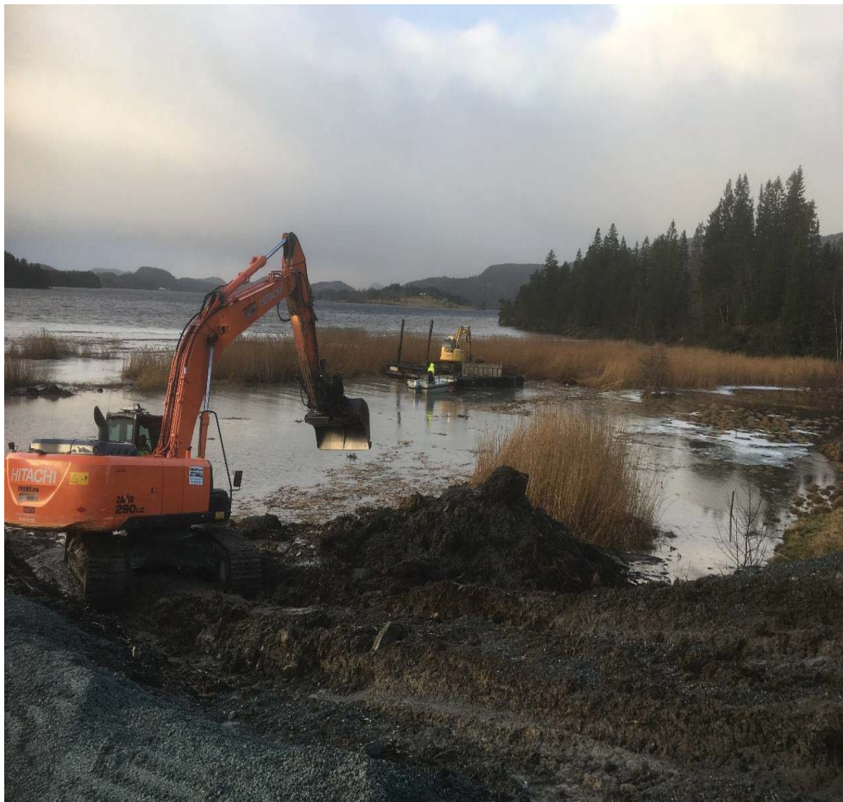
Figur 12. Restaureringsarbeid i Hammervatn naturreservat, 23.01.2017. Fjerning av akkumulert organisk materiale og kutting av taksrør. Gravemaskin lengst unna i bilde tar opp masse og plasserer massen på lekteren, mens gravemaskin lengst frem i bildet skufler massene over til lastebil. Gjennomført av lokal entreprenør. Foto: Hilde Ely-Aastrup, Fylkesmannen Trøndelag.
