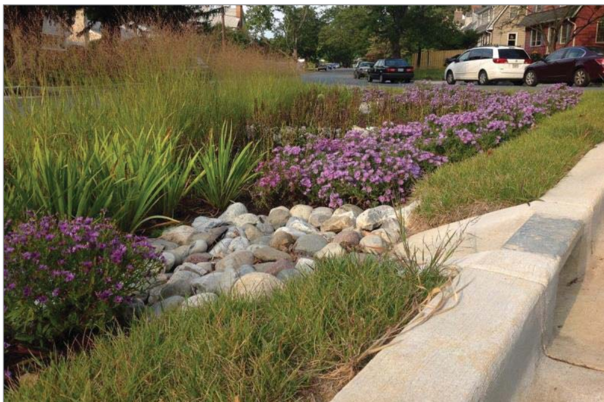
Figur 3.4 Eksempel på utforming av regnbed fra Montgomery County i USA. (Bilde er gjengitt med tillatelse fra Montgomery County, MD USA, Department of Environmental Protection.)
