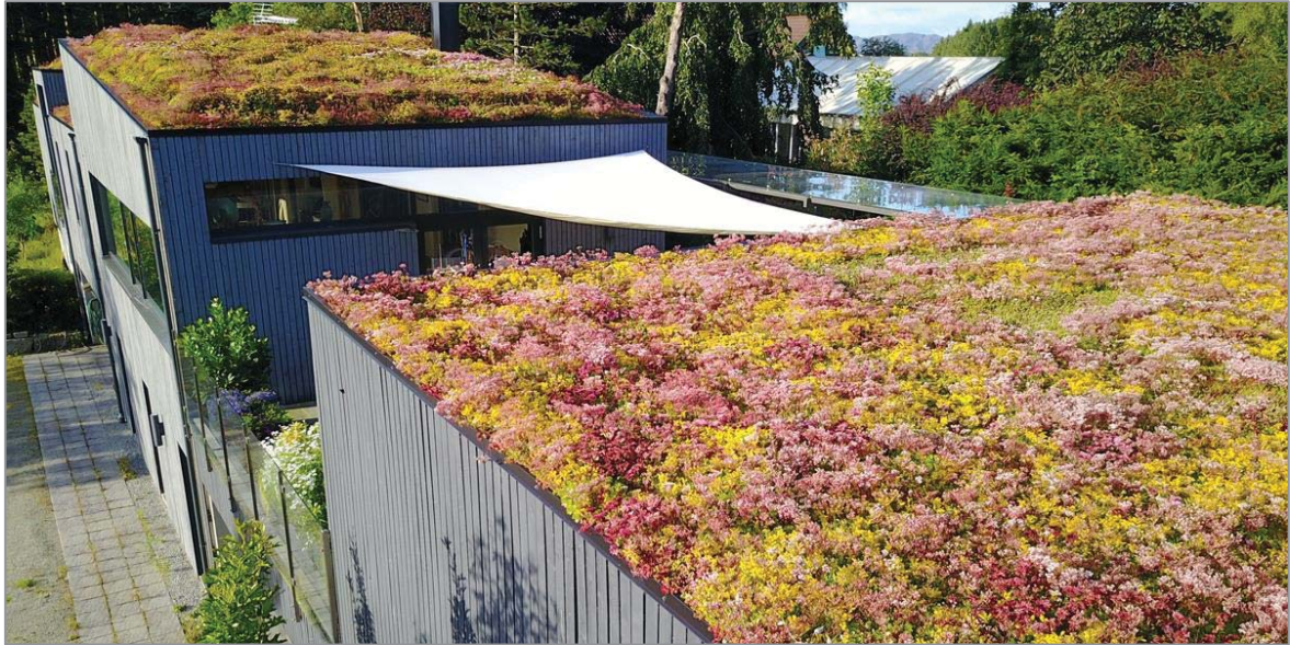
Figur 3.1 Eksempel på ekstensive tak med sedumbesplanter fra Berknapp.no. (Bildet er gjengitt med tillatelse fra Berknapp.no)
