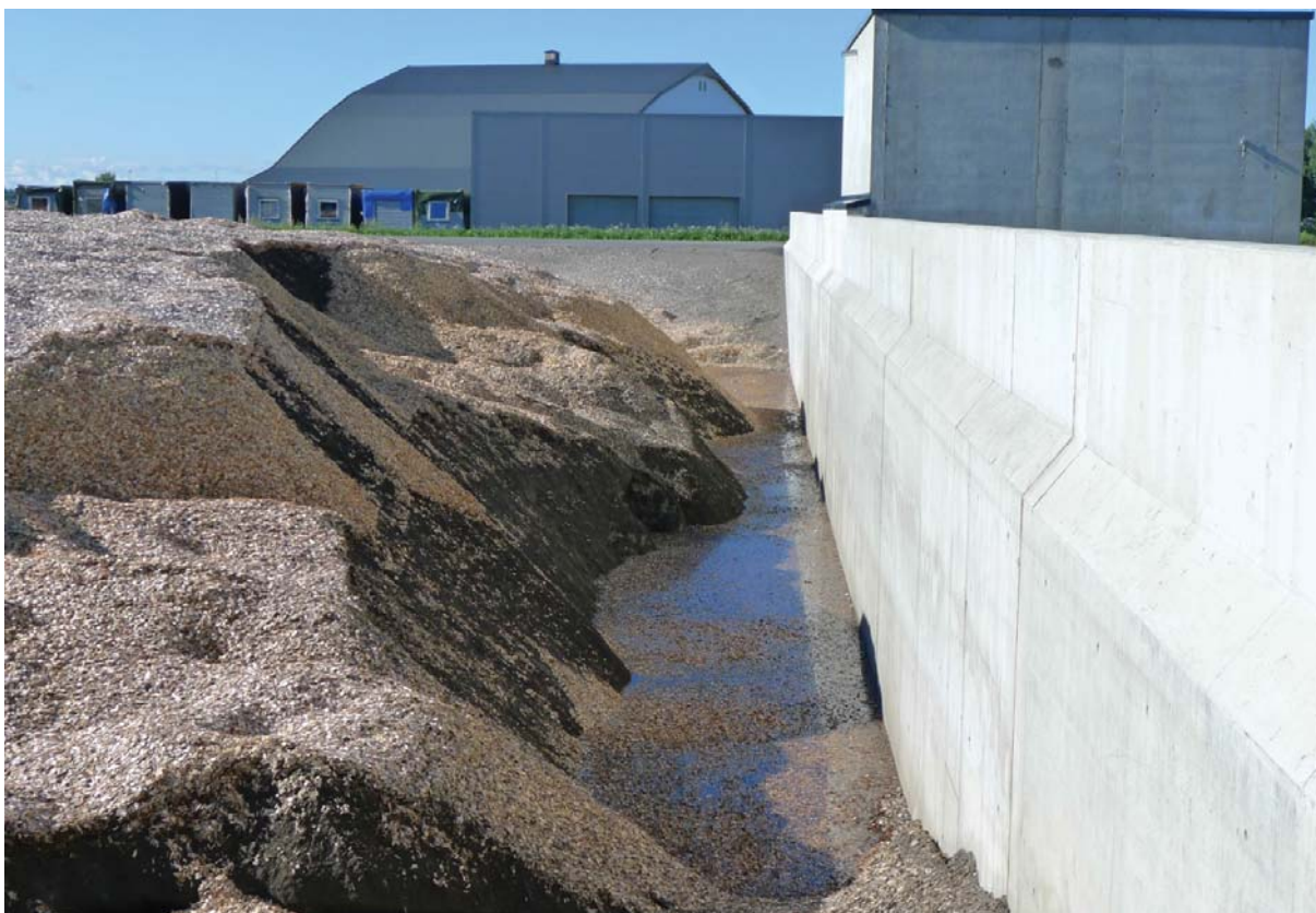
Bilde 6 Innløp til pumpehus under driftsfase
