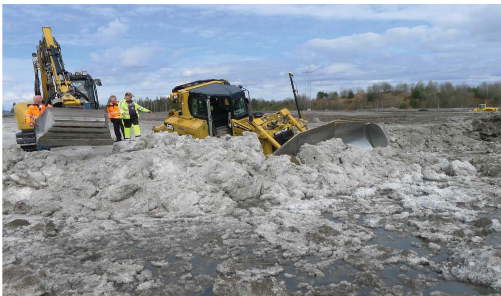
Bilde 4 (Forsøk på) Utjevning av snø i basseng med gravemaskin og bulldoser
