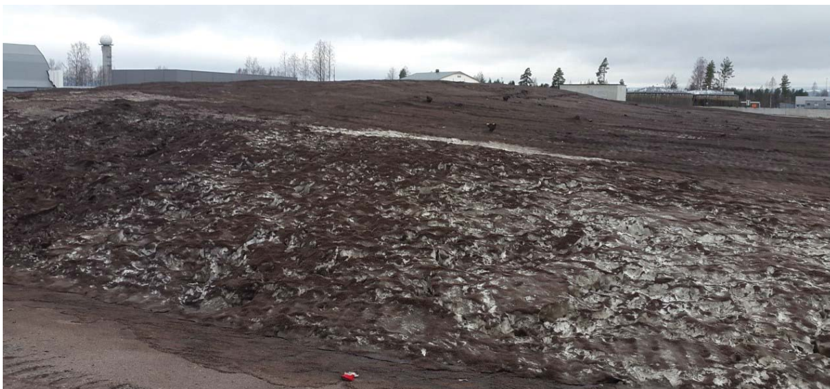
Bilde 9 Snølageret før det ble isolert 4. april 2017
