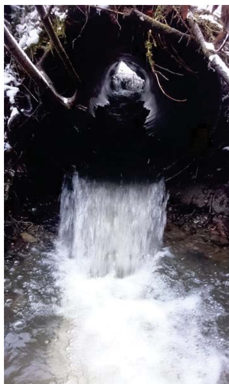
Figur 30: Kulvert som trolig stopper en del fisk i Sone 4 i Kvellstadbekken. Foto: Lovise Vårhus
