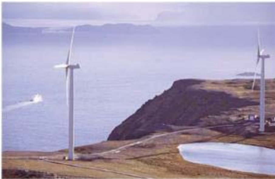
Figur 3.2 Storskala vindturbin. Kjelde: (Eidsiva 2008).
