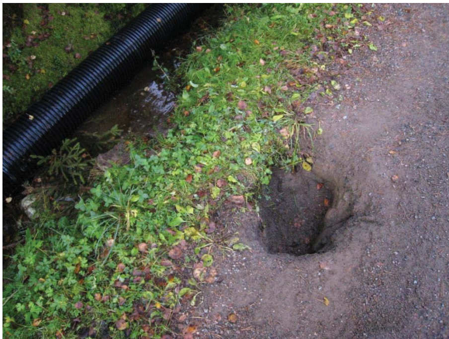
Figur 24: Hull med størrelse 30 x 30 cm i vei grunnet betongrør som har glidd fra hverandre. Sted: Enebakk. Foto: Ole Stabekk, 2013.
