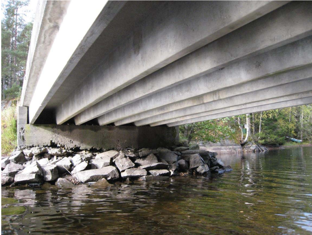
Figur 2: En betongbjelkebro med betongdekke som krysser Raudsjøen i Østmarka. Foto: Ole Stabekk, 2013.
