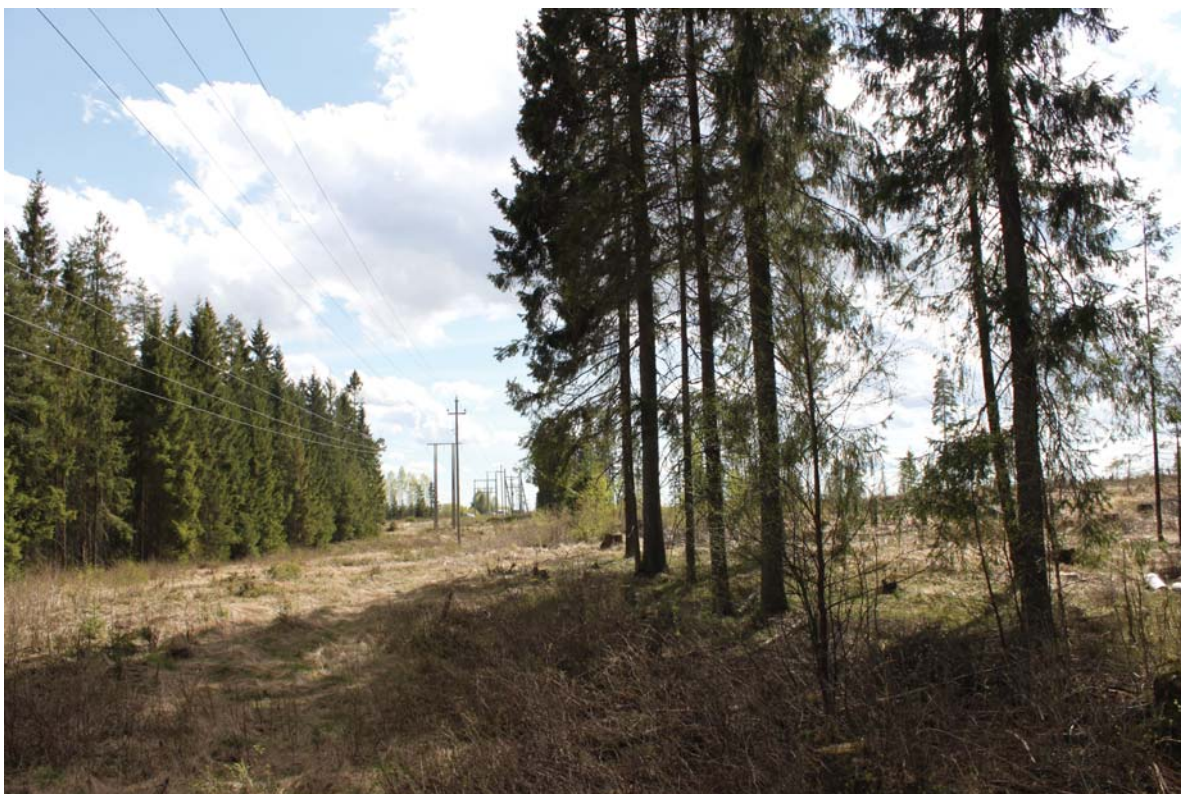
Foto 3: Kantskog observert i område 7. Store trær som har stor sannsynlighet for å falle over linja ved kraftig vind
