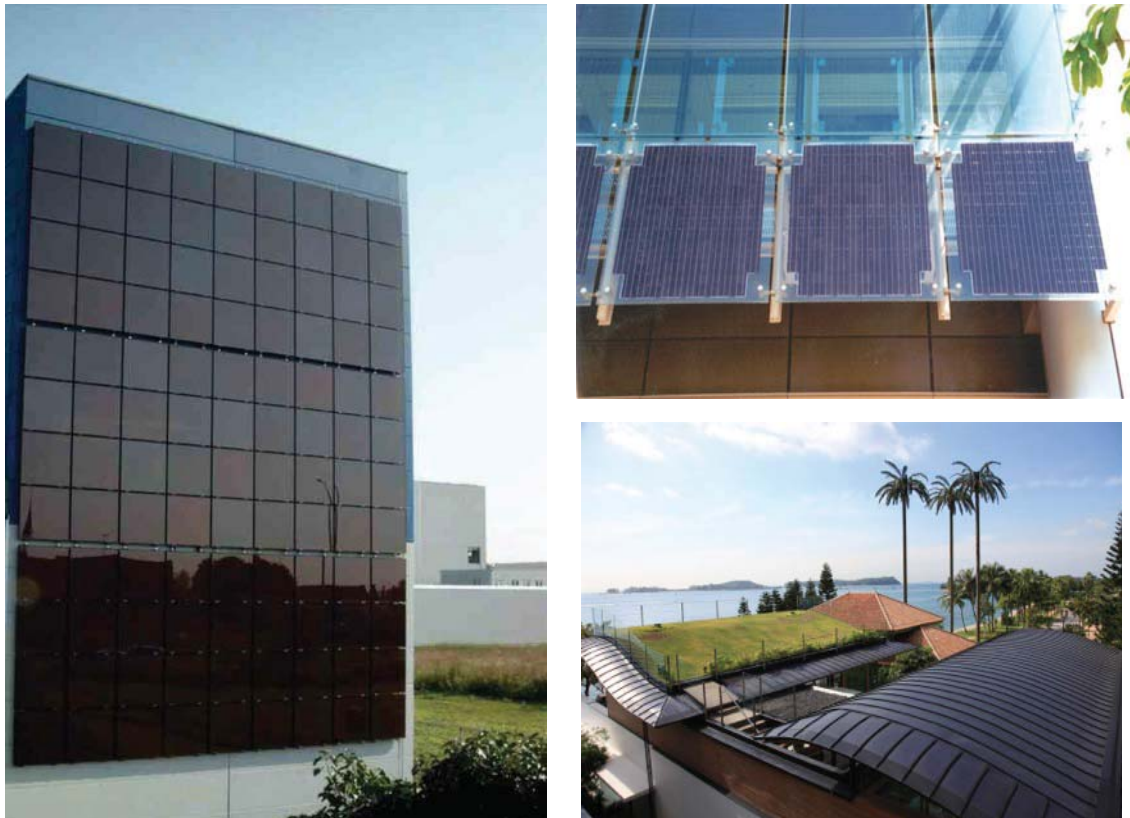
Figur 2 – Bilde til venstre viser BIPV fra Nanometer Technology (Nanometer-Technology), bilde øverst til høyre er solceller integrert i glassfasade (Kwan 2013) og bilde nederst til høyre er av et solcelleanlegg integrert i tak (Solar)
