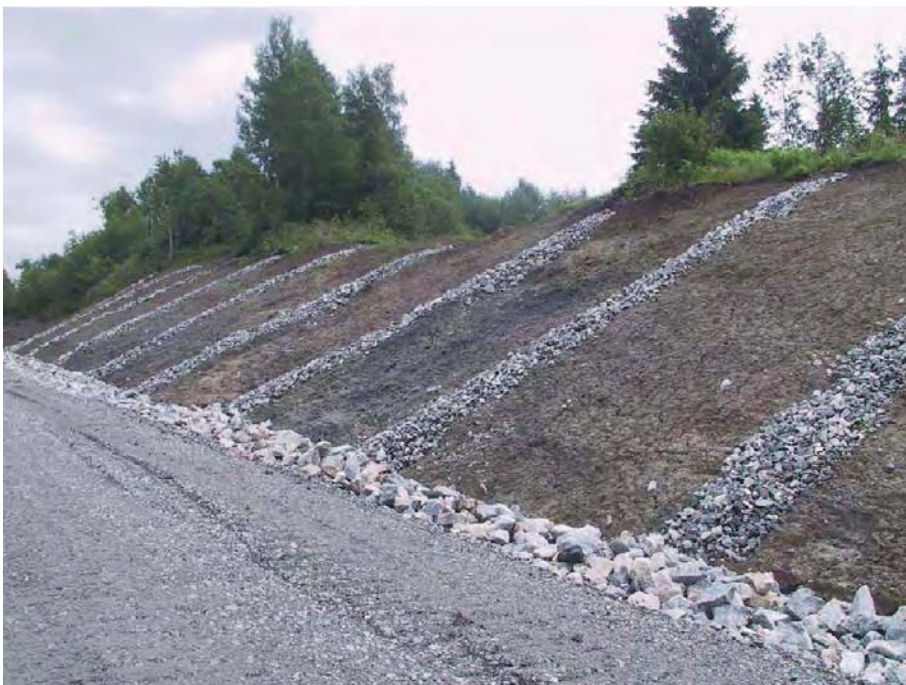
Figur 33. (figure 245.4 i HB018) Skråningsdren vinkelrett på vegggrøft (Rv 120, Nannestad. Foto: Arvid Sagbakken, SVV)
