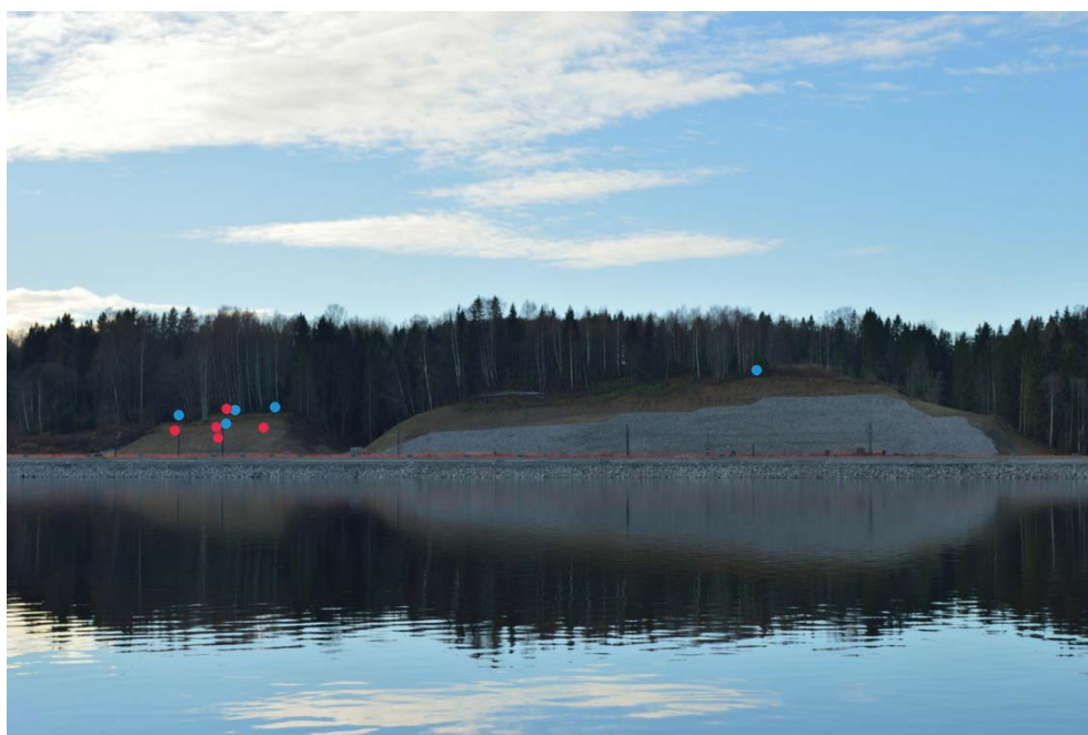
Figur 13. Skjæringene sett fra østsiden av Vormå. Blå punkter markerer plassering av grunnvannsbrønner, og røde punkter jordfuktsensorer. Tre av brønnenes plassering er ikke synlig på bildet da disse ligger lenger inne i landskaper og derfor er dekket av skog. (Aavatsmark 2013)
