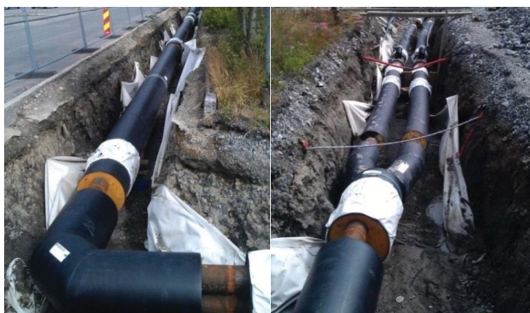
Figur 6: Twinrør langs Brekkeveien / Skille mellom twinrør og enkeltrør mellom Brekkeveien og jernbanen
