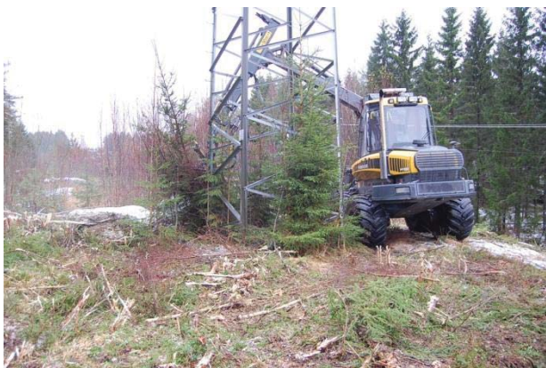
Figur 14. Maskinell rydding rundt mastebein i Sørmarkafeltet. Her må det ryddes manuelt.
