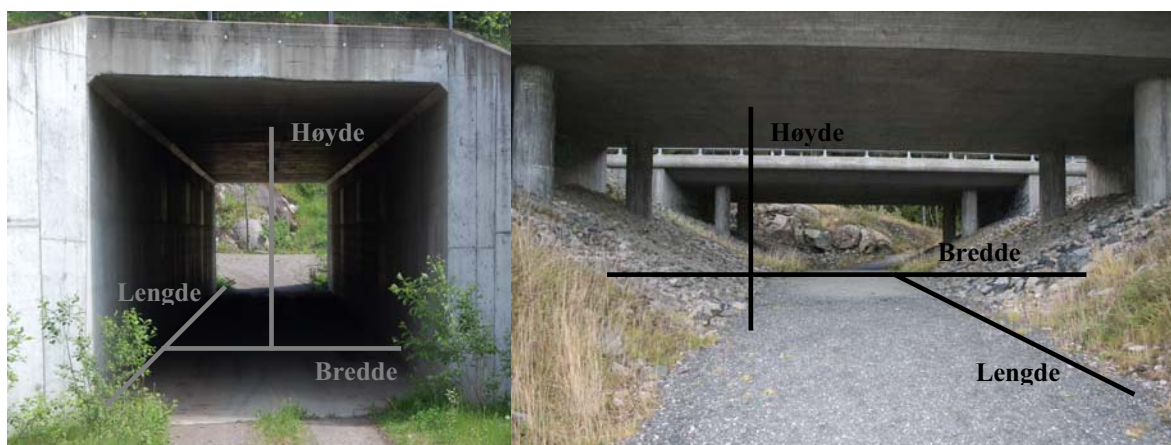
Figur 4. I underganger som i bildet til venstre er det trukket fra noen meter i bredden, hvor det er for lavt til at elg kan passere, i forhold til underganger som vist til høyre, der veggene er rette. Foto: V. Kristiansen og G. O. Strætkvern.
