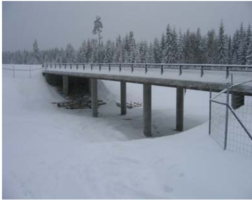
Figur 2.3 Slettmoen undergang på riksveg 35 sett fra sørøst. Foto: Ragna Flatla (08.02.2006).
