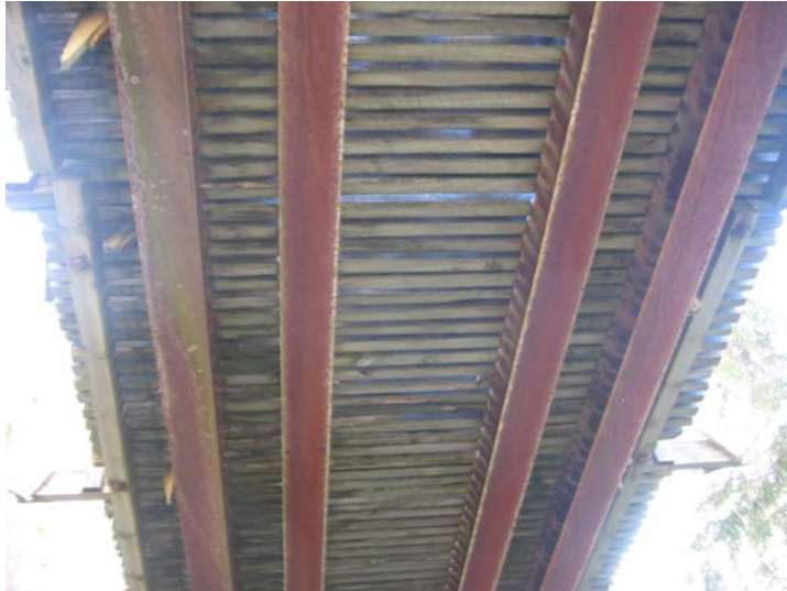
Bilde 2: Eksempel på hovedbæresystem og sekundærbæresystem (Fredrik C. Løvenskiold 2006)
