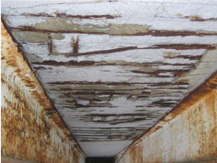
Bilde 21: Armeringen trenger gjennom betongen (Fredrik C. Løvenskiold 2006)
