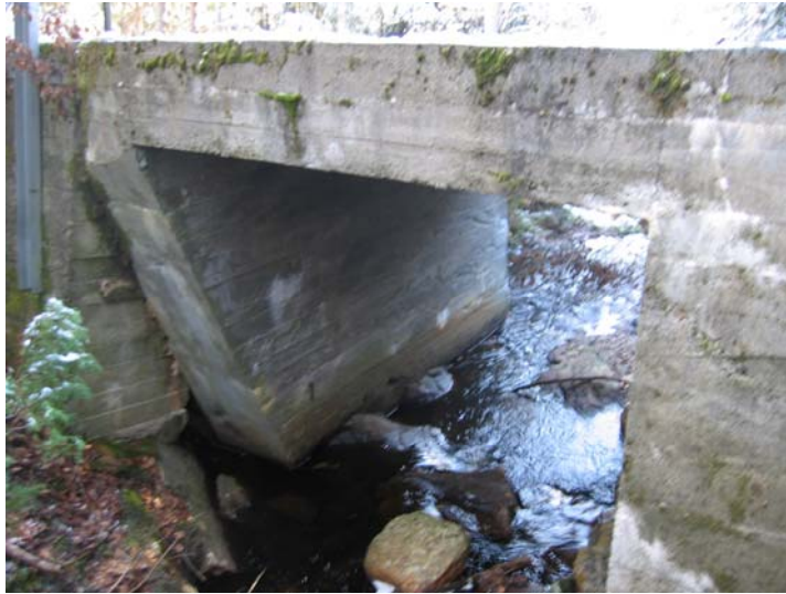
Bilde 14: Plasstøpt betongplatebro (Fredrik C. Løvenskiold 2006)
