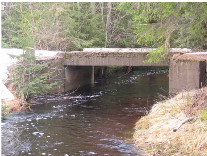
Bilde 25: Plasstøpt betongplate (Fredrik C. Løvenskiold 2006)
