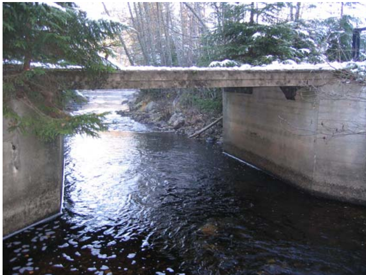
Bilde 17: Plasstøpt betongplatebro (Fredrik C. Løvenskiold 2006)
