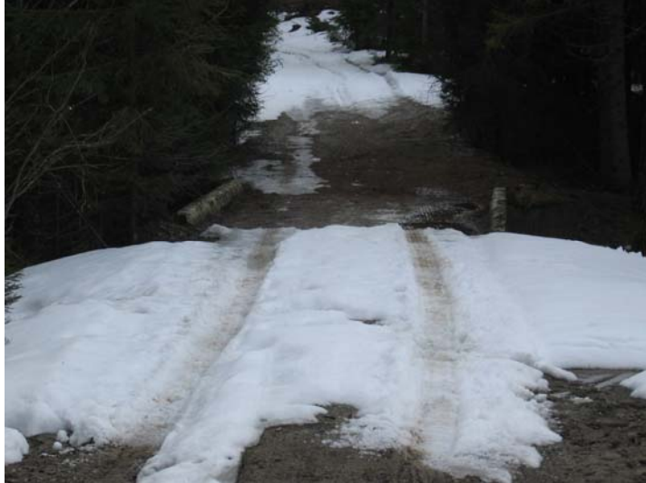
Bilde 26: Innkjøringsvinkelen er feil i forhold til vegen (Fredrik C. Løvenskiold 2006)
