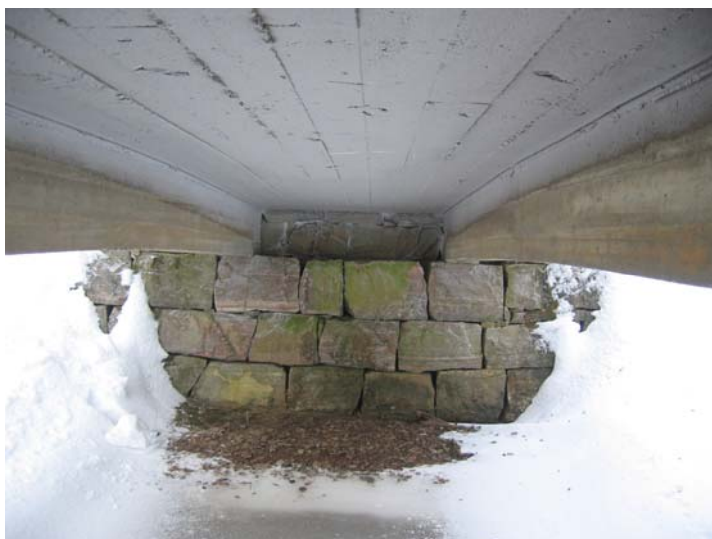
Bilde 24: Plasstøpt betongbro (Fredrik C. Løvenskiold 2006)
