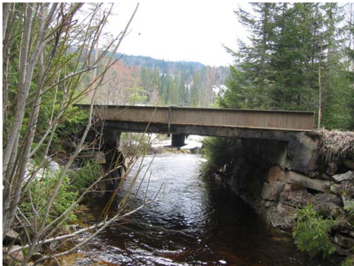
Bilde 22: Plasstøpt betongplate (Fredrik C. Løvenskiold 2006)
