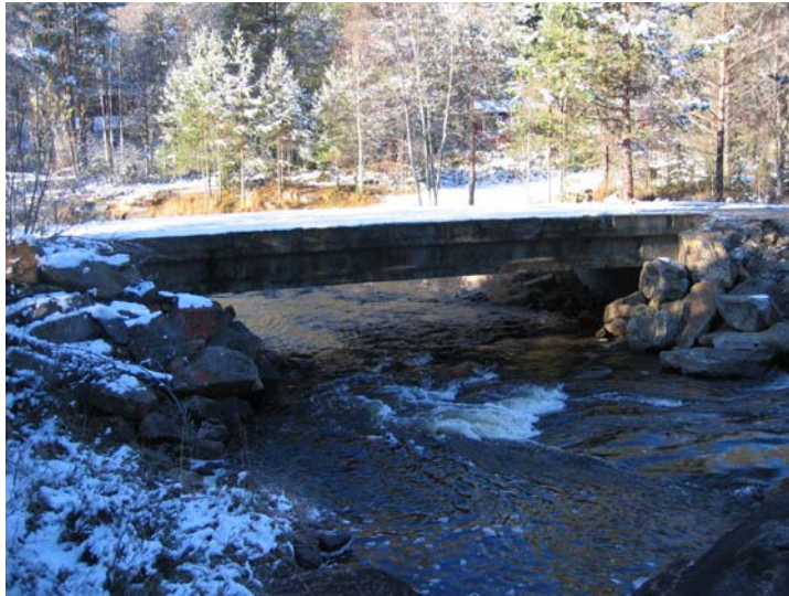
Bilde 4: Bro 1, prefabrikerte betongbjelker med betongplate (Fredrik C. Løvenskiold 2006)
