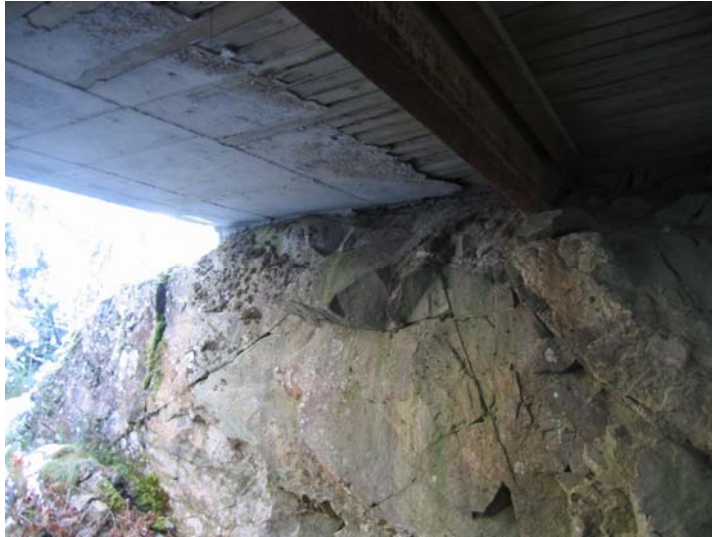
Bilde 16: 1,5 m breddeutvidelse utført i betong (Fredrik C. Løvenskiold 2006)
