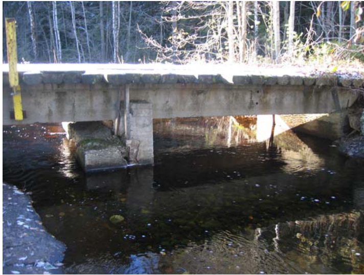
Bilde 11: Bro 4, prefabrikerte betongbjelker med tredekke (Fredrik C. Løvenskiold 2006)
