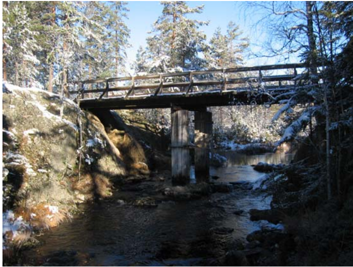
Bilde 8: Bro 3, H – bjelker av stål med tredekke (Fredrik C. Løvenskiold 2006)
