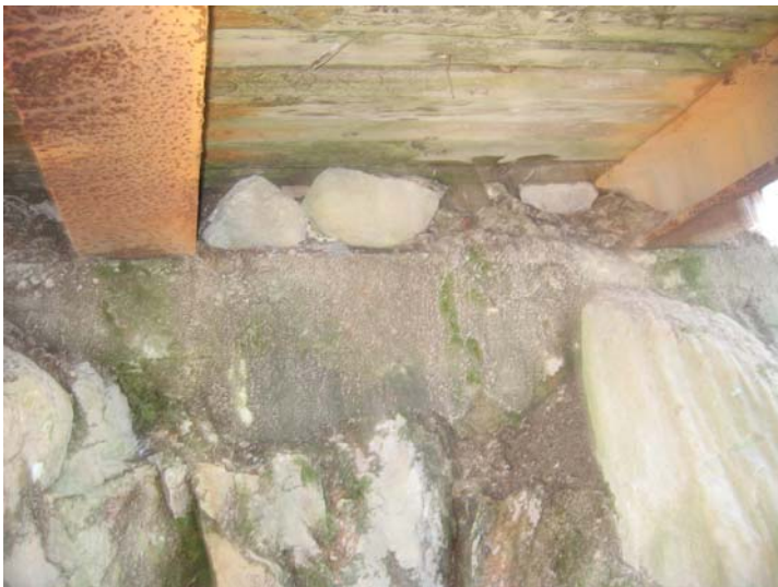
Bilde 10: H – bjelkene ligger i kontakt med jord (Fredrik C. Løvenskiold 2006)
