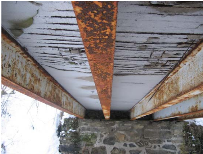
Bilde 18: 5 stk H – bjelker av stål med betongplate (Fredrik C. Løvenskiold 2006)
