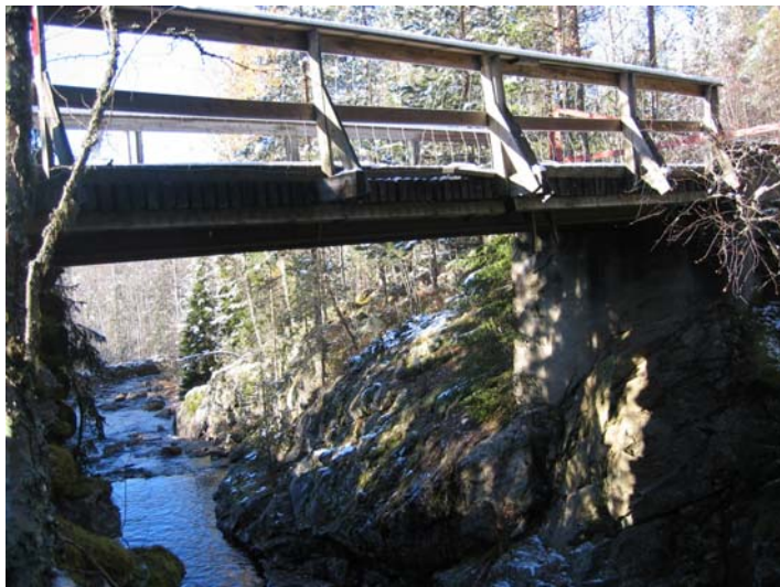
Bilde 6: Bro 2, H – bjelker av stål med tredekke (Fredrik C. Løvenskiold 2006)
