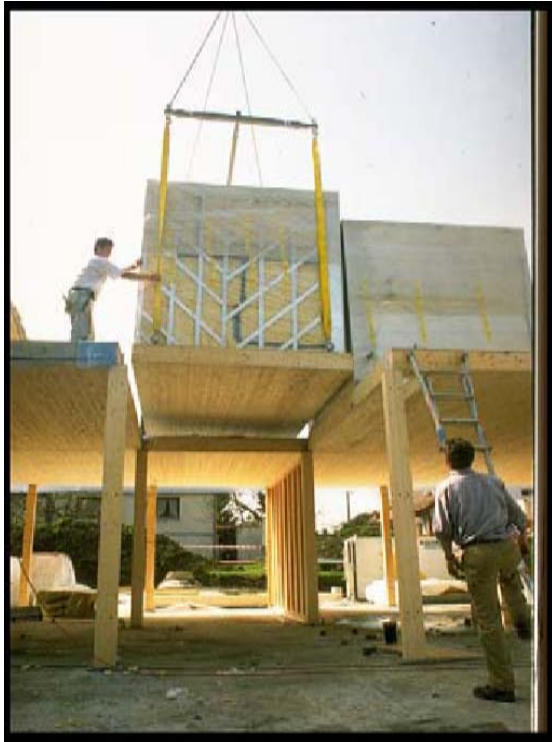
Bilde 2: Montering av massivtreelementer (Kilde: Larsen 2003)
