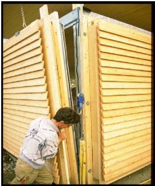
Bilde 1: Montering av massivtreelementer (Kilde: Larsen 2003)
