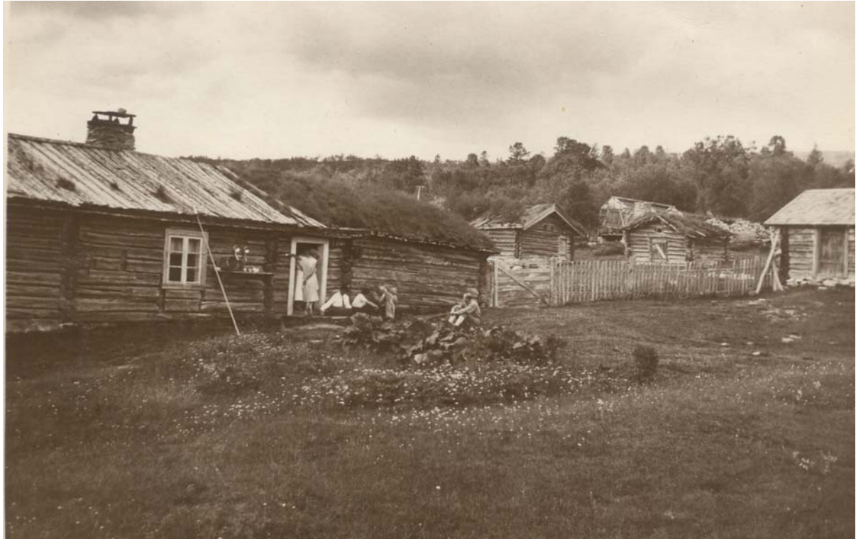
Bilde 26: Nystusetra. Her har seterhuset både torvtak og bordtak. I bakgrunnen står stallen, bua og saga. Foto: Ukjent. Bildet er utlånt av Stein Broen.
