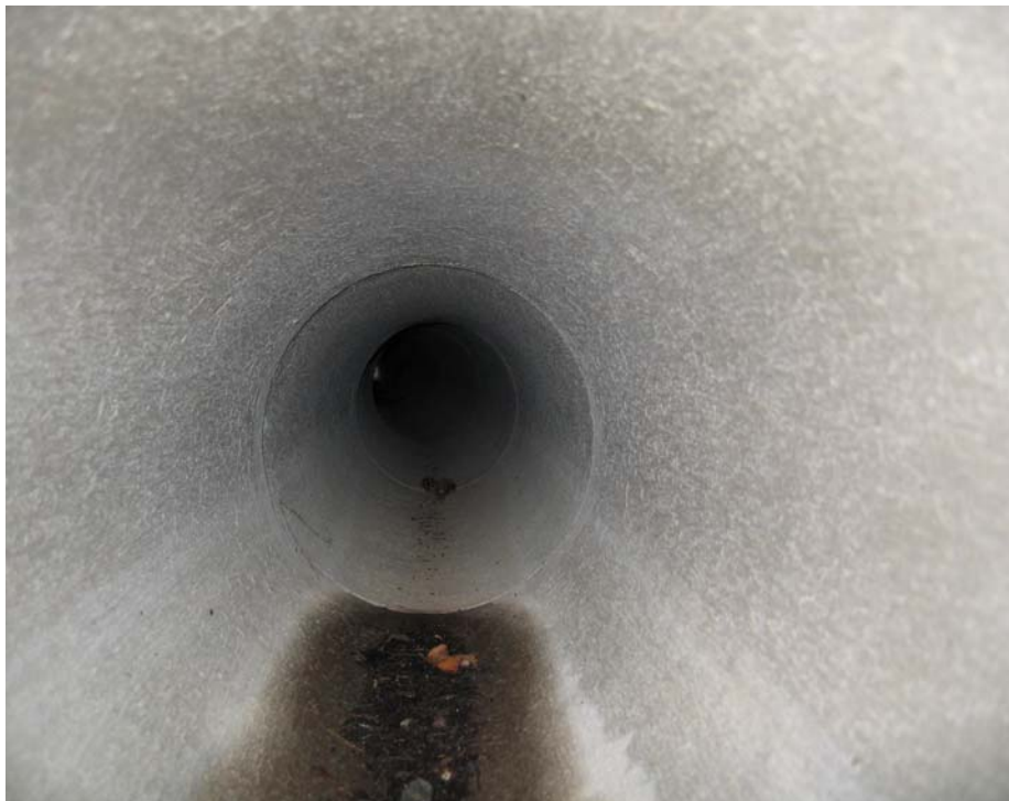
Bilde 4 Bildet viser en betongkulvert som er buet horisontalt. Man kan så vidt skimte lyset fra utløpet i enden av kulverten.
