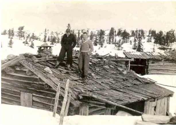
Bilde 27: Vardefjellseter før 1940. Foto: ukjent, utlånt av: Peder Toeneiet.
