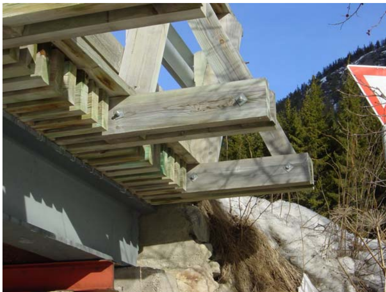
Bilde 4: Eksempel på brudekke av tre som holder dagens krav (Øvre Uvdal bru).
