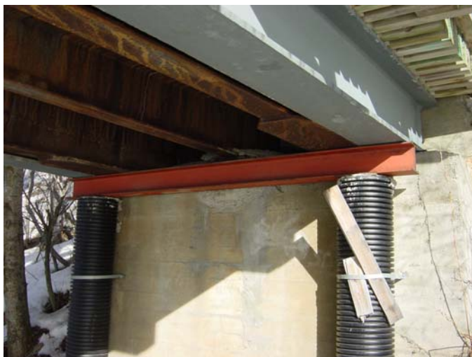
Bilde 2: Eksempel på forsterking av brukar (Øvre Uvdal bru).
