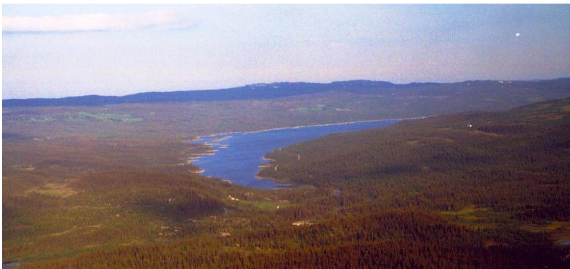
Figur 3: Dokkfløymagasinet med omkringliggende områder fotografert sørøstover fra Ormtjernkampen (1128 m.o.h.). Kun den nordvestlige delen av magasinet er med i bildet. Foto: K. L. Jensen
