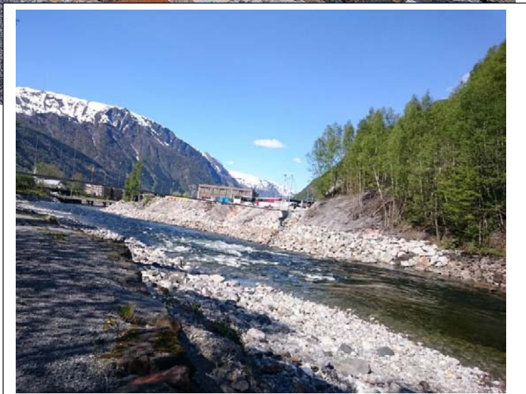
Fig. 15. Opo nedanfor Hjølløbrua ved 15 m 3 /s (øvt) og nedanfor Ivarshølen ved 39 m 3 /s (nedst)(Foto: Knut Jøsendal). Elvefar og elvesider er totalt omforma av forbyggingar utført av NVE. Det er no blitt eit elvefar som skal få store vassføringar lettast mogeleg til sjøen.
